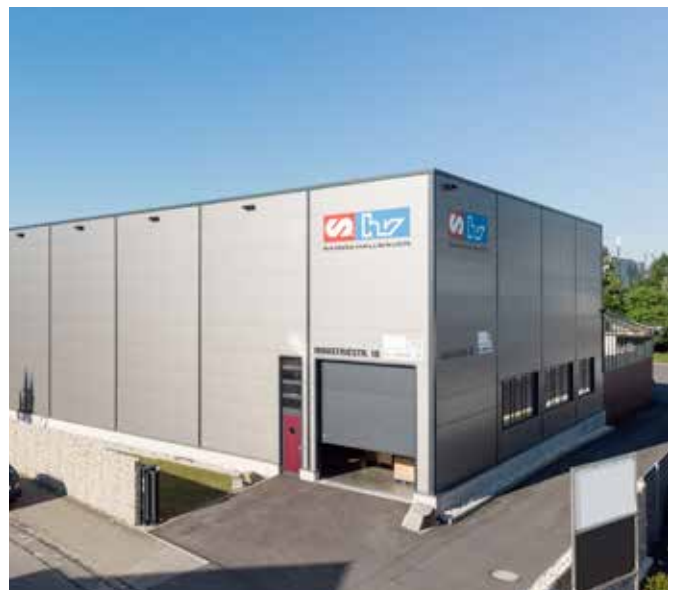
Logistikzentrum der SAMOA-HALLBAUER GmbH in Viernheim.
