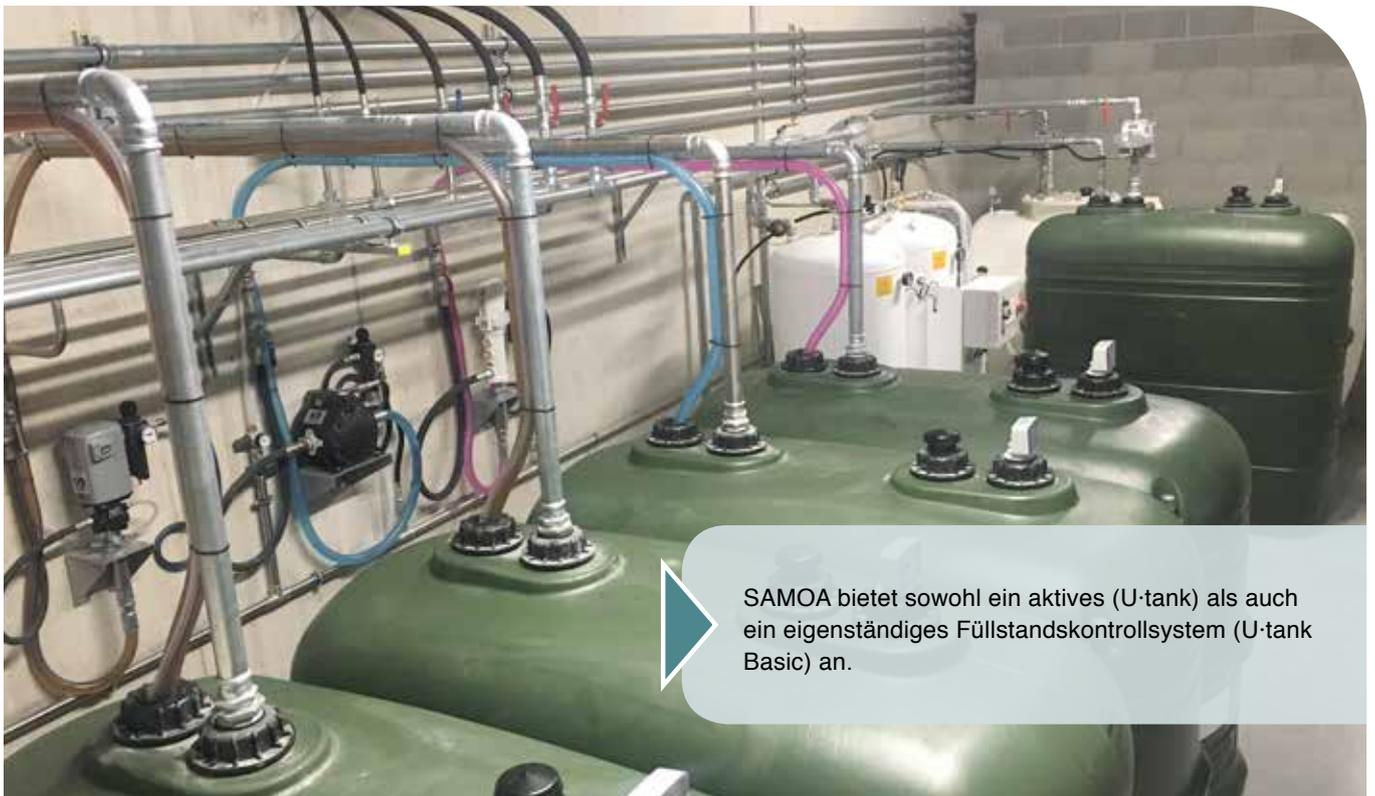
SAMOA bietet sowohl ein aktives (U-tank) als auch ein eigenständiges Füllstandkontrollsystem (U-tank Basic) an.
