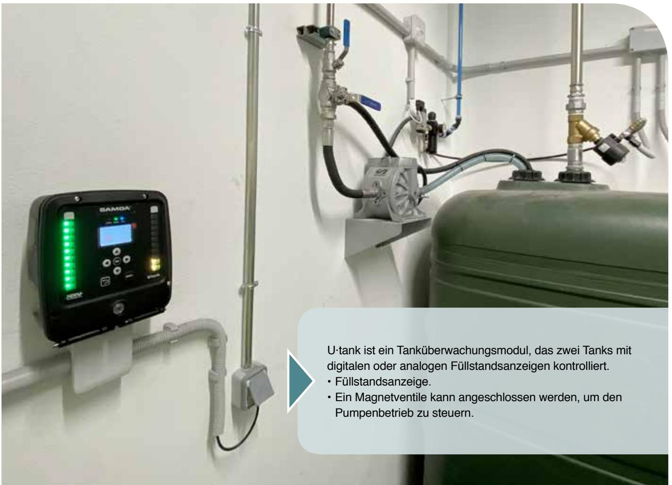
U-tank ist ein Tanküberwachungsmodul, das zwei Tanks mit digitalen oder analogen Füllstandsanzeigen kontrolliert.
