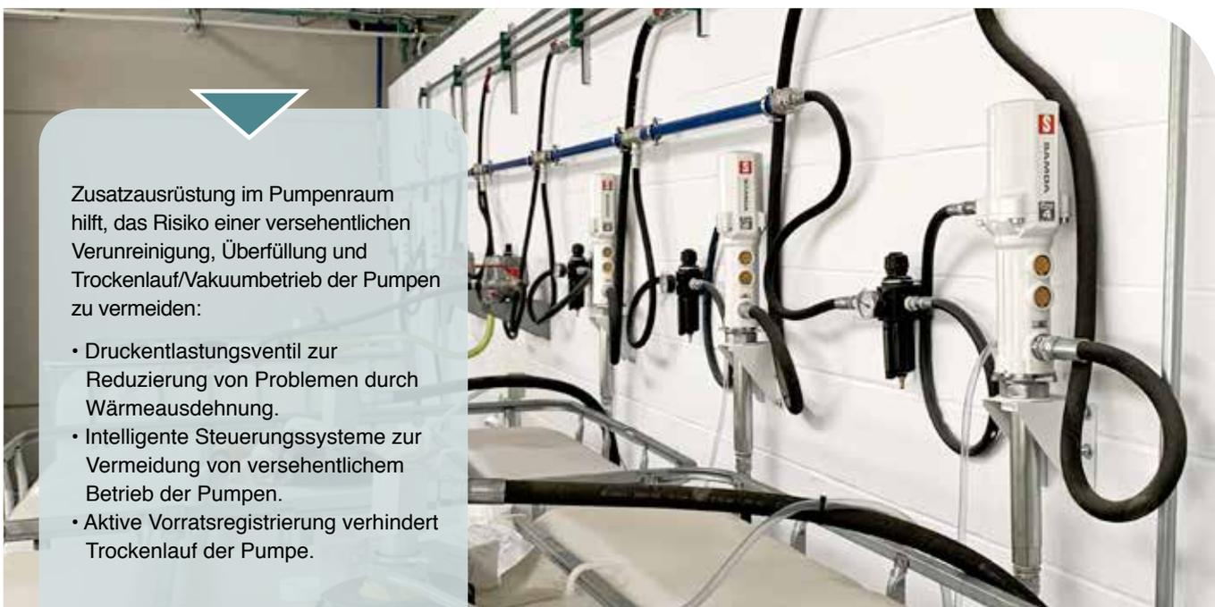
Zusatzrüstung im Pumpenraum hilft, das Risiko einer versehentlichen Verunreinigung, Überfüllung und Trockenlauf/Vakuumbetrieb der Pumpen zu vermeiden:
